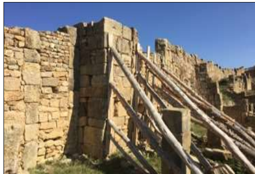
Figure 6 : Etayement du mur du cardo secondaire (ph. auteure )
